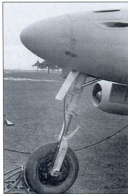
Me 262 V5 с опытной неубирающейся носовой стойкой шасси
