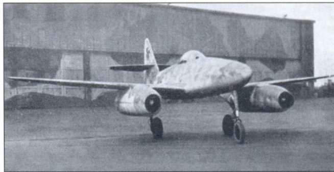
Me 262 V5 с опытной неубирающейся носовой стойкой шасси
