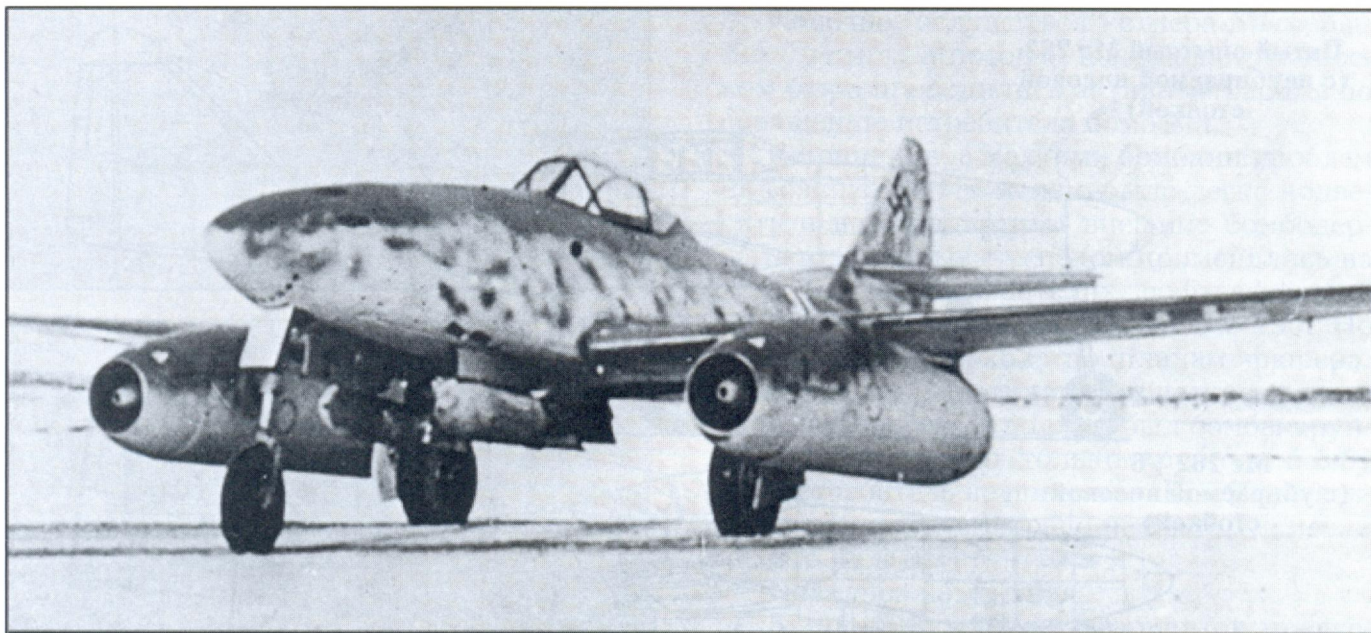
Истребитель-бомбардировщик Me 262A-2 «Штурмфогель» с двумя бомбами на подфюзеляжных держателях
